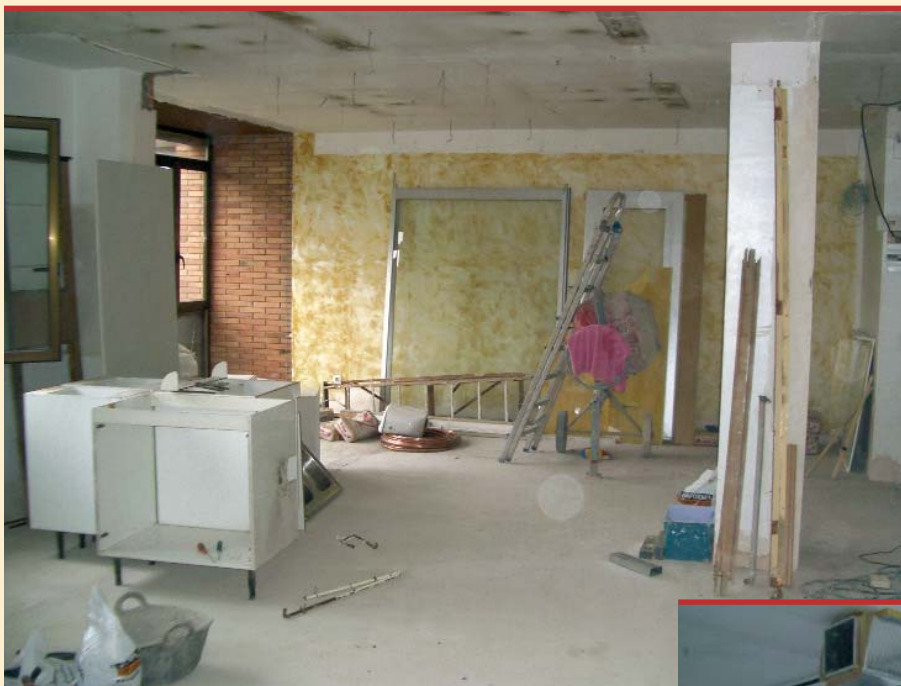
Sobre estas líneas, y a la derecha, dos momentos de las obras de restauración en Mateo Arquitectura .
